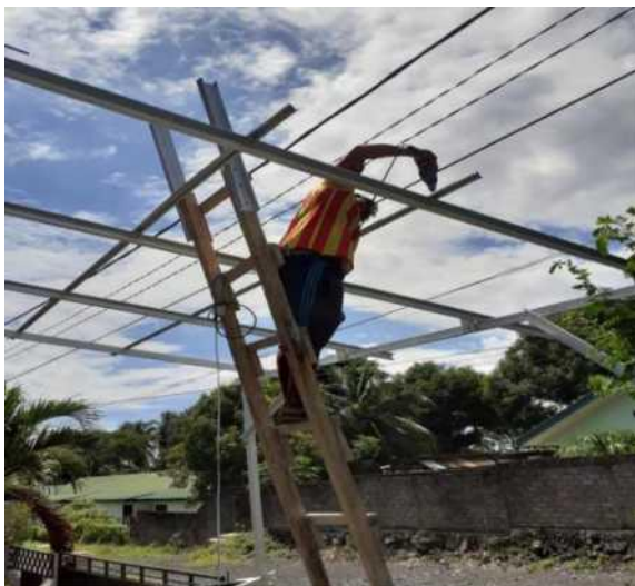
Gambar 3.17. Demonstrasi cara pembuatan garasi atap seng.
