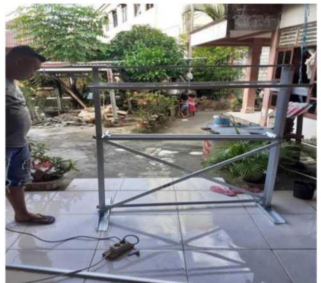
Gambar 3.12. Peserta pelatihan melakukan praktikan dua tiang dengan panjang 1,48 meter, dan 120 cm. Gambar 3.13. Uji coba Gantungan handuk masih goyah Gambar 3.15. Konstruksi sederhana gantungan handuk berbasis baja ringan .
